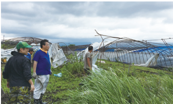
7月の台風3号で倒壊した旧式ハウス
