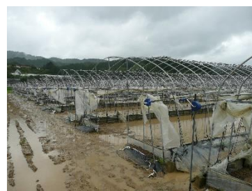
台風による浸水被害の様子
