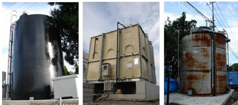
自己負担で掘削した井戸3基
