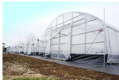
新設の「高瀬式 14 回転ハウス」
